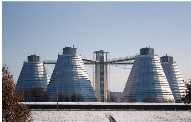
Fig. 4. Planta de tratamiento de aguas residuales de Mních (Alemania).
